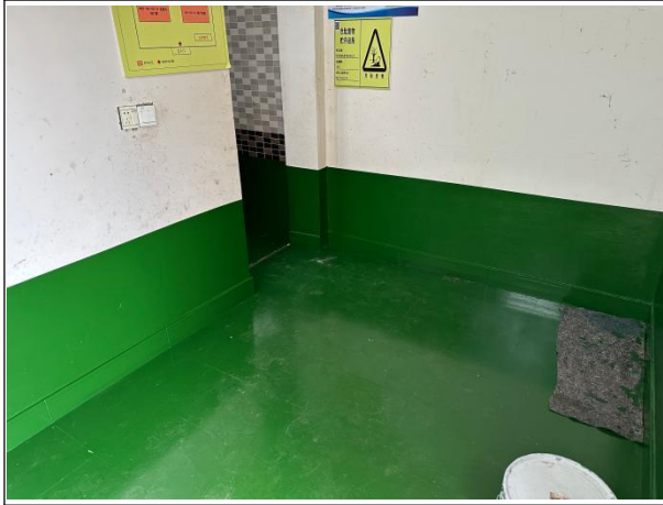
危险废物暂存库
