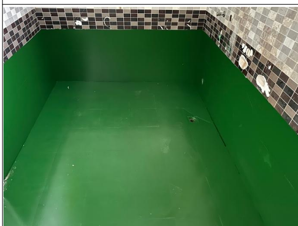
危险废物暂存库
