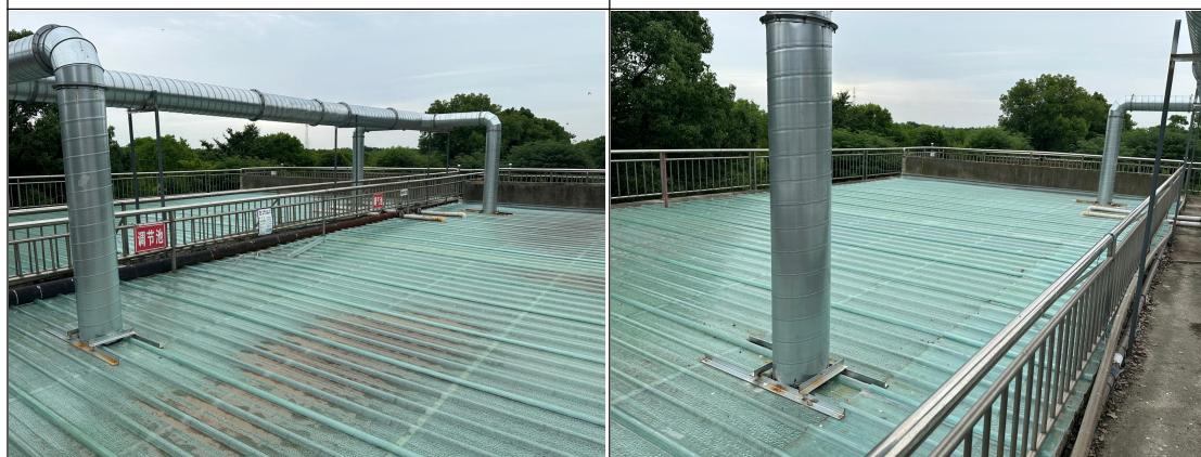
污水处理池加盖
