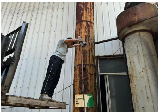
有组织废气排放口
