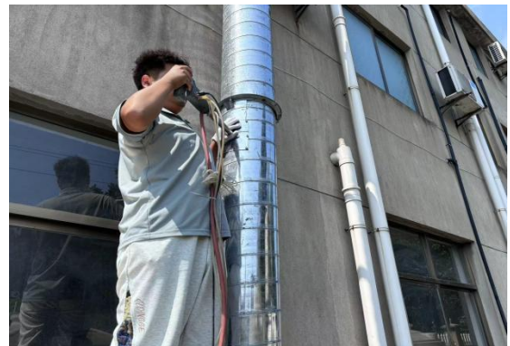
抛丸废气排放口
