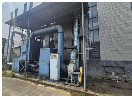
发泡、成型、烘干、浇注废气处理设施
