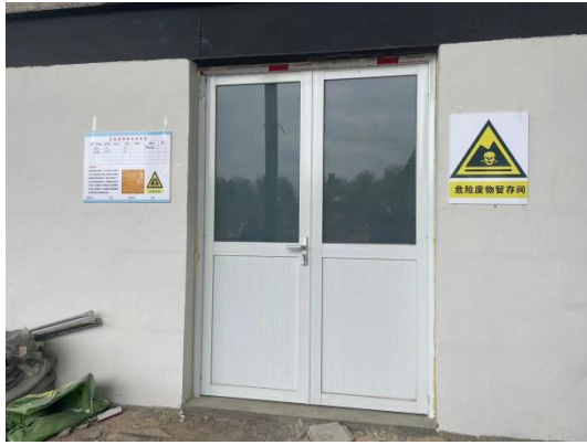
危废暂存场所
